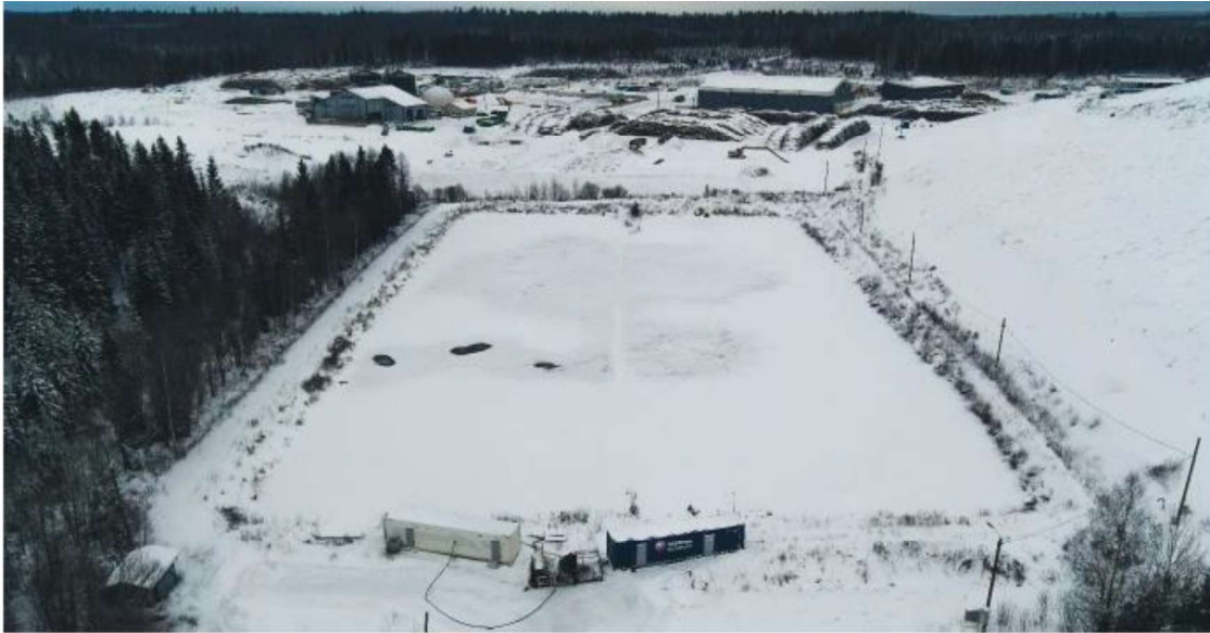
Kuva 3 Ilmakuva Jäte kukkon tasausaltaasta ja pilotointikonteista. Nykyisin kenttä- ja suotovesistä koostuva tasaaltaan vesi pumpataan pumppauskaivon kautta Kuopion veden operoimalle kunnalliselle jäteveden puhdistamolle.
